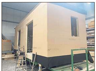
Im Rohbau sieht das KH-Modular so aus.
